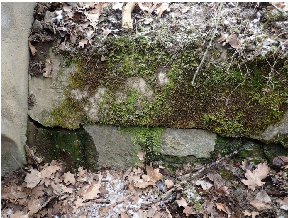
Foto 3: Průsaky vody mezi spáry kamenů v křídle
